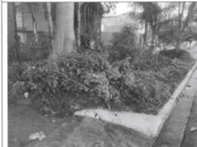
FOTO 05 – DEMOLIÇÃO DE RAMPA E PISO TÁTIL
